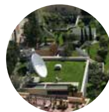
Extension de réseaux LAN
